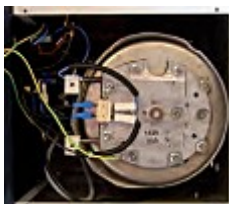
Resistencia fuera del tanque para evitar daños de corrosión
